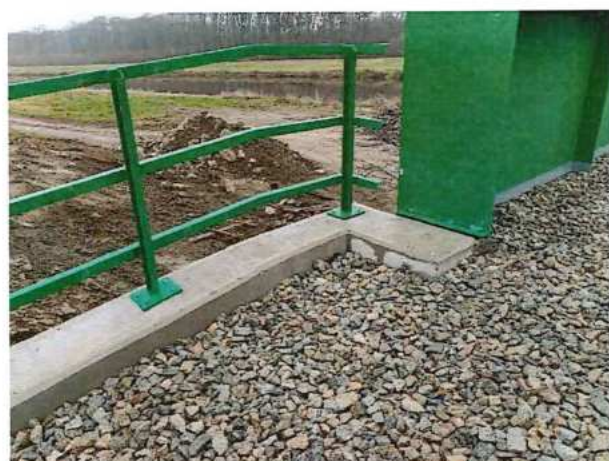
UČS 12 Vodivé prepojenie zábradlí a ukofajnenie
